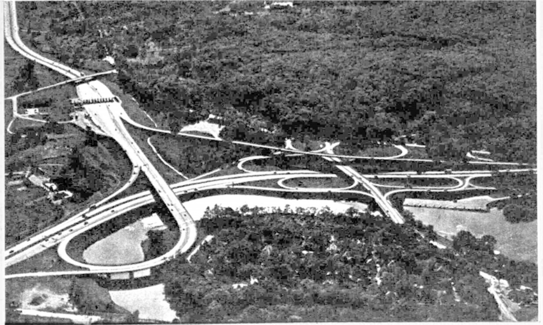
VISTA AEREA DE PASOS A DESNIVEL EN MASSACHUSETTS.
