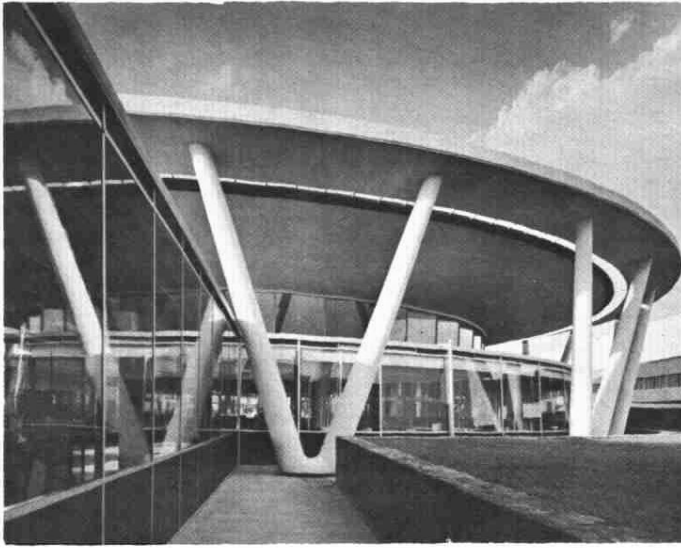
Cubierta circular colgante. Laboratorios Sharp & Dome. Arq. J. Sordo Madaleno. 1962
