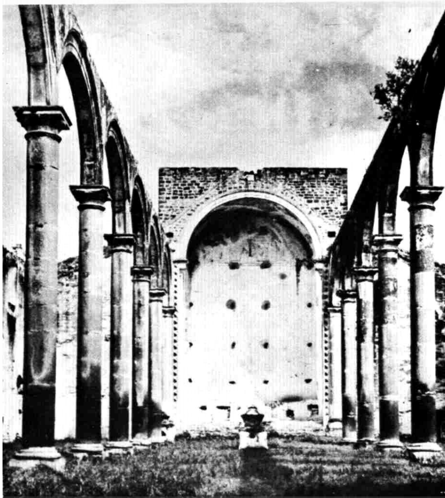
Iglesia del Convento franciscano de Tecali, Edo. de Puebla. Siglo XVI. Entre los pocos ejemplos de tres naves tuvo cubierta de madera a dos aguas, un solo altar y no hay huellas de adorno.
