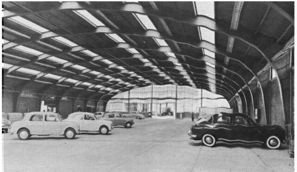
Cubierta, 32 m. de claro. Diesel Nacional, Arqs. Landa
