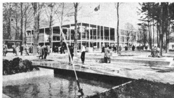
2 Canadá. Estructura de acero.
