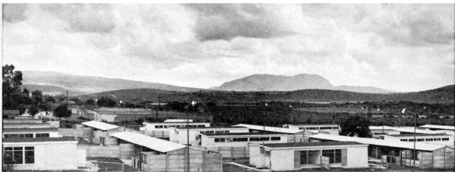
Vista de la zona de habitación.
