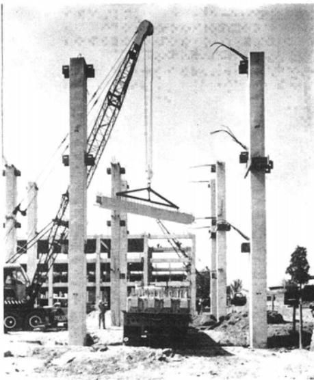
Detalles de la colocación de elementos prefabricados en el plantel Mixcoac.
