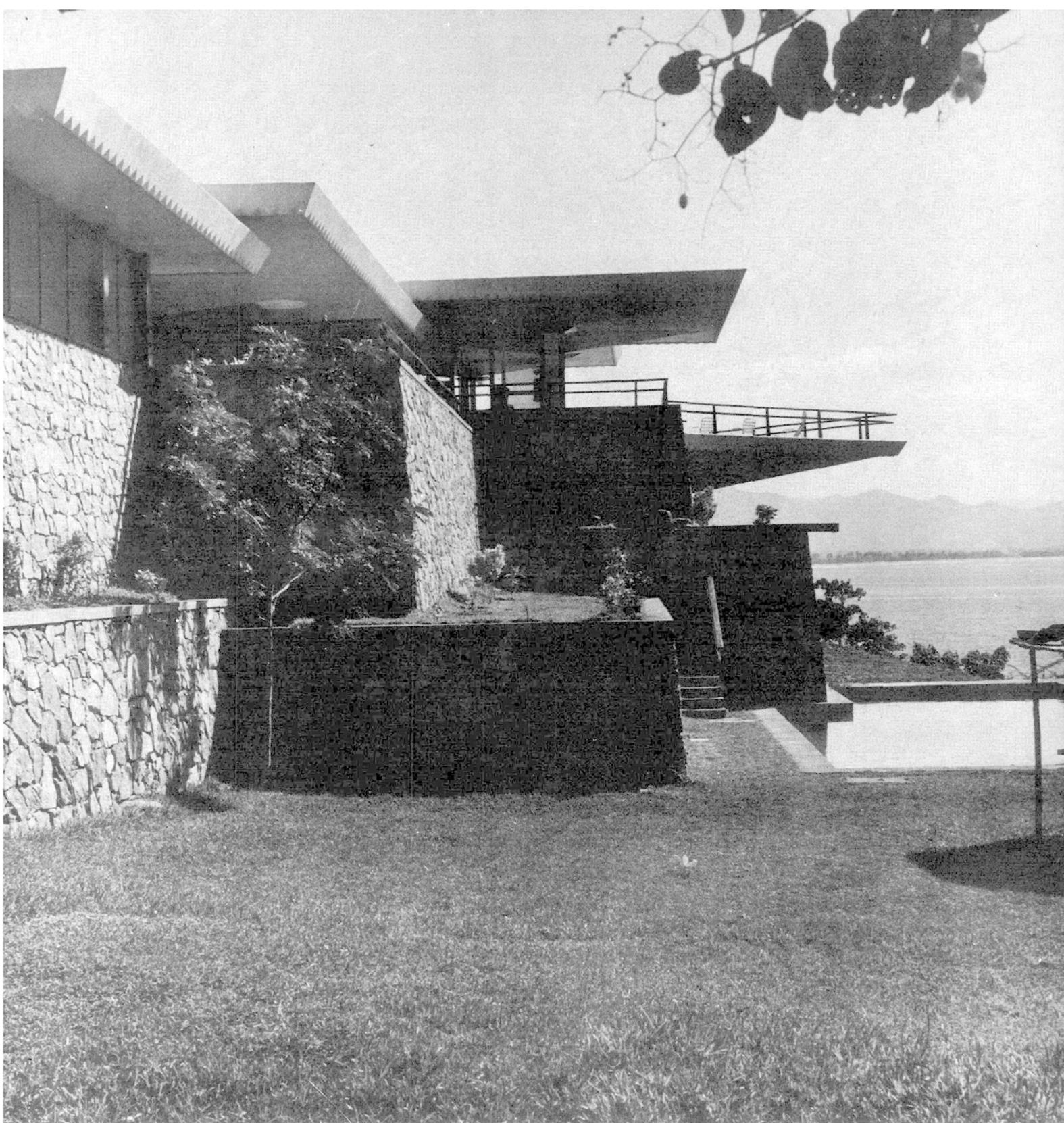
La cubierta es una loza plana ahuecada con tubos, con armado principal en una sola dirección (paralela a la dirección longitudinal de la casa), apoyada en traveses que disminuyen de dimensión hacia las puntas, tomando una forma piramidal sumamente alargada. Los techos se escalonaron siguiendo los diferentes niveles de piso y según las necesidades de altura de los distintos espacios.
