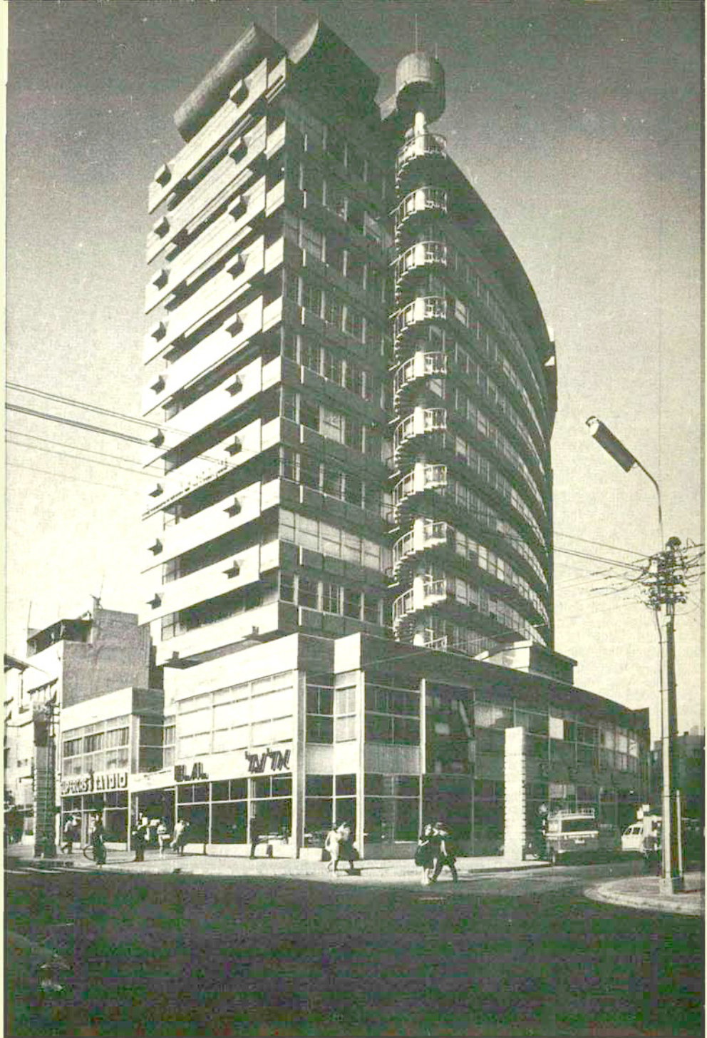
Edificio de oficinas en Tel-Aviv.
