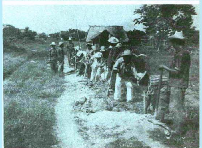
Trabajos para la introducción del agua potable en Cihuatepec, Oax.
