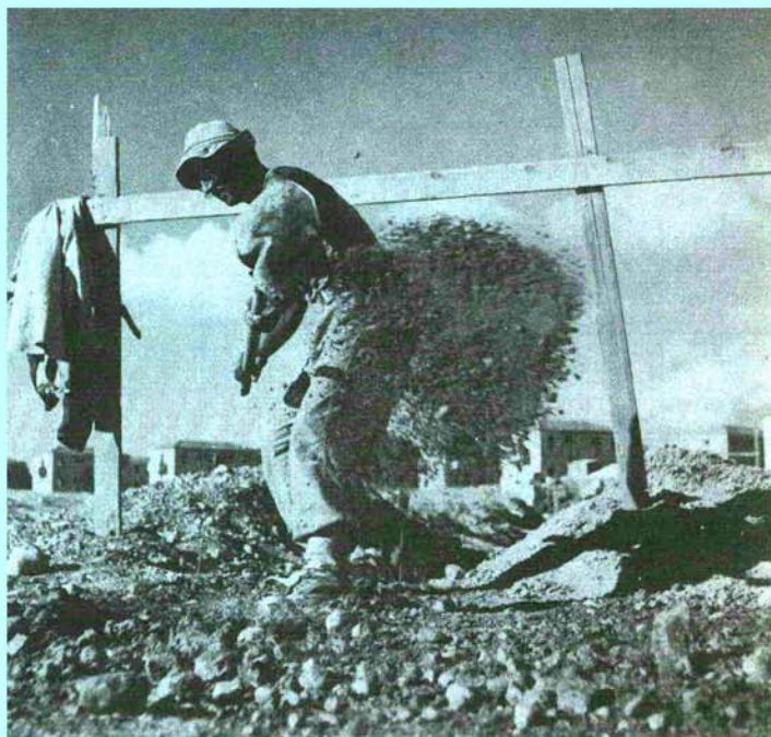
Un Kibutz en construcción.
