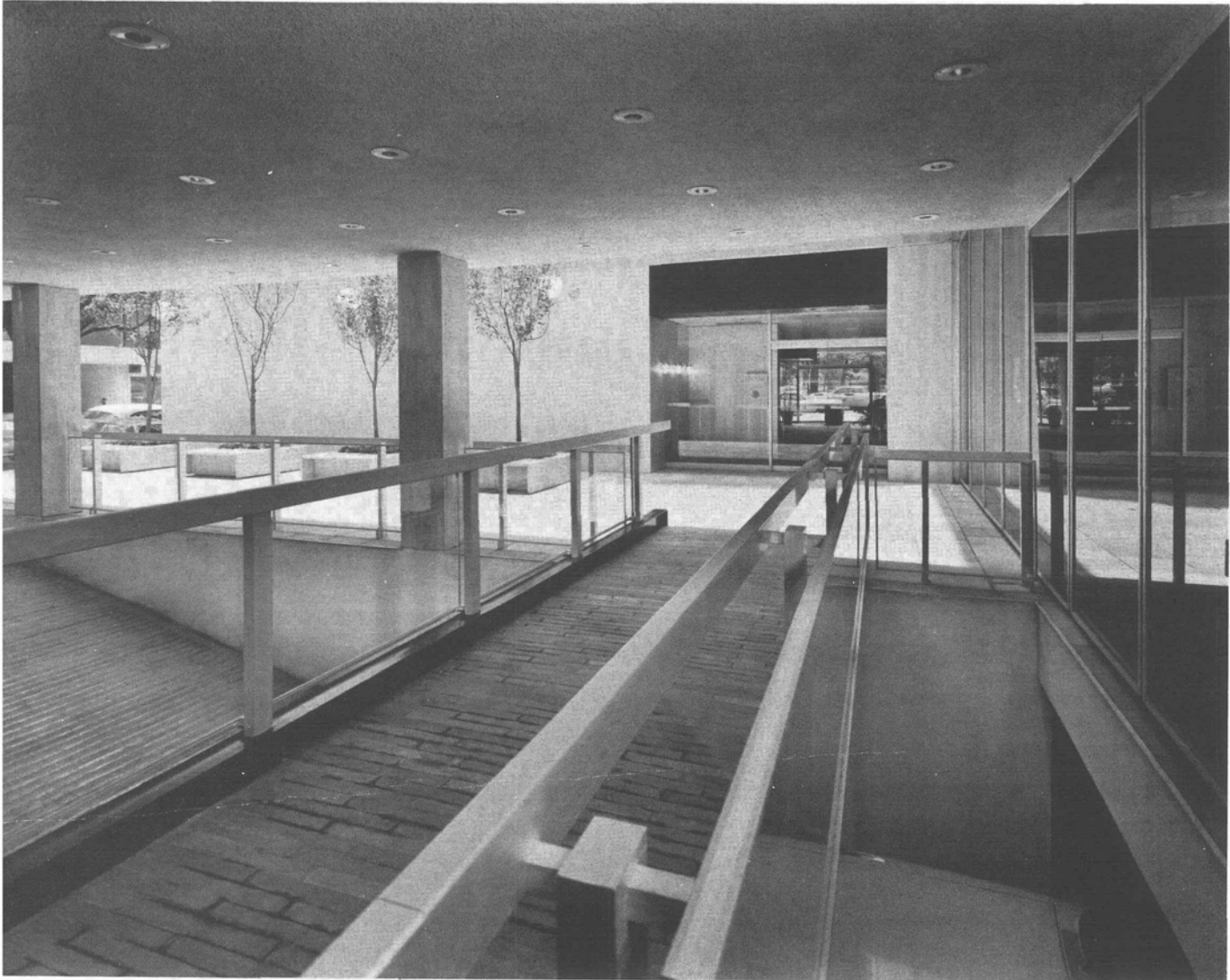
Rampa del estacionamiento.
