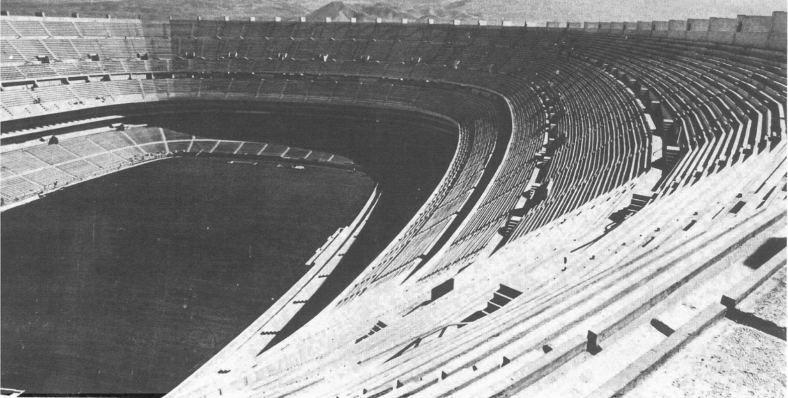
Por la configuración de esta obra, desde cualquier punto existe una buena visual.
