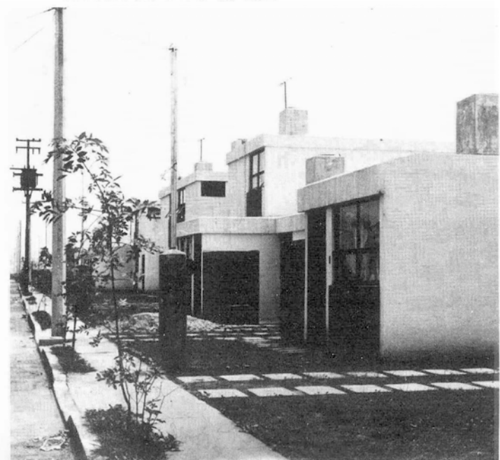
Conjunto de 608 casas habitación localizado en el fraccionamiento Viveros del Valle.
