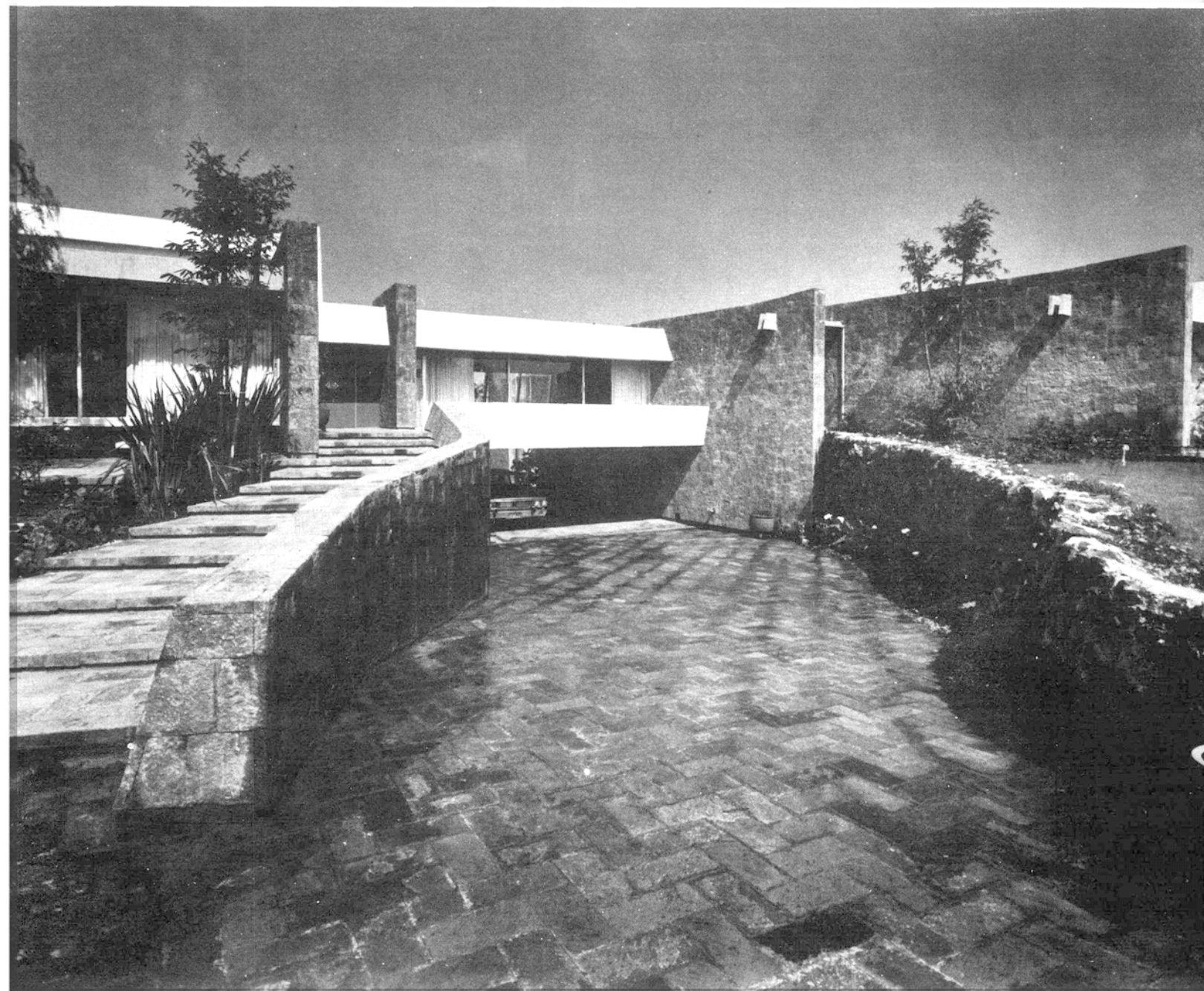
Aprovechando la configuración del terreno se logró integrar los servicios en la parte baja.
