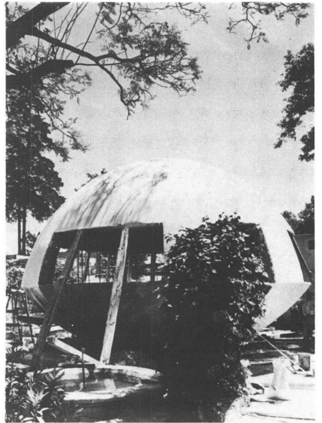
Primer análisis estructural. Maqueta de yeso, escala natural.
