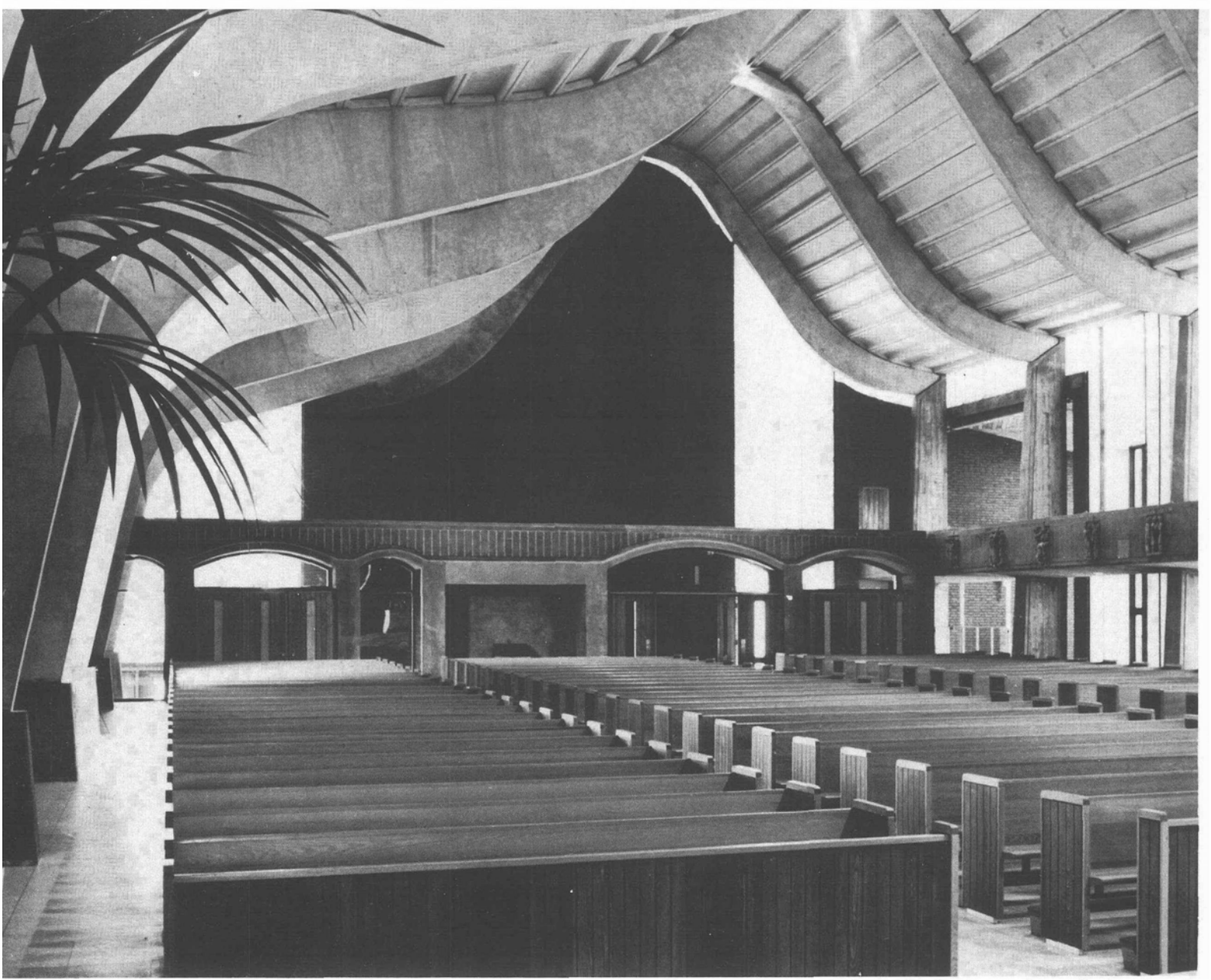
Aspecto interior de esta obra realizada a base de elementos precolados.
