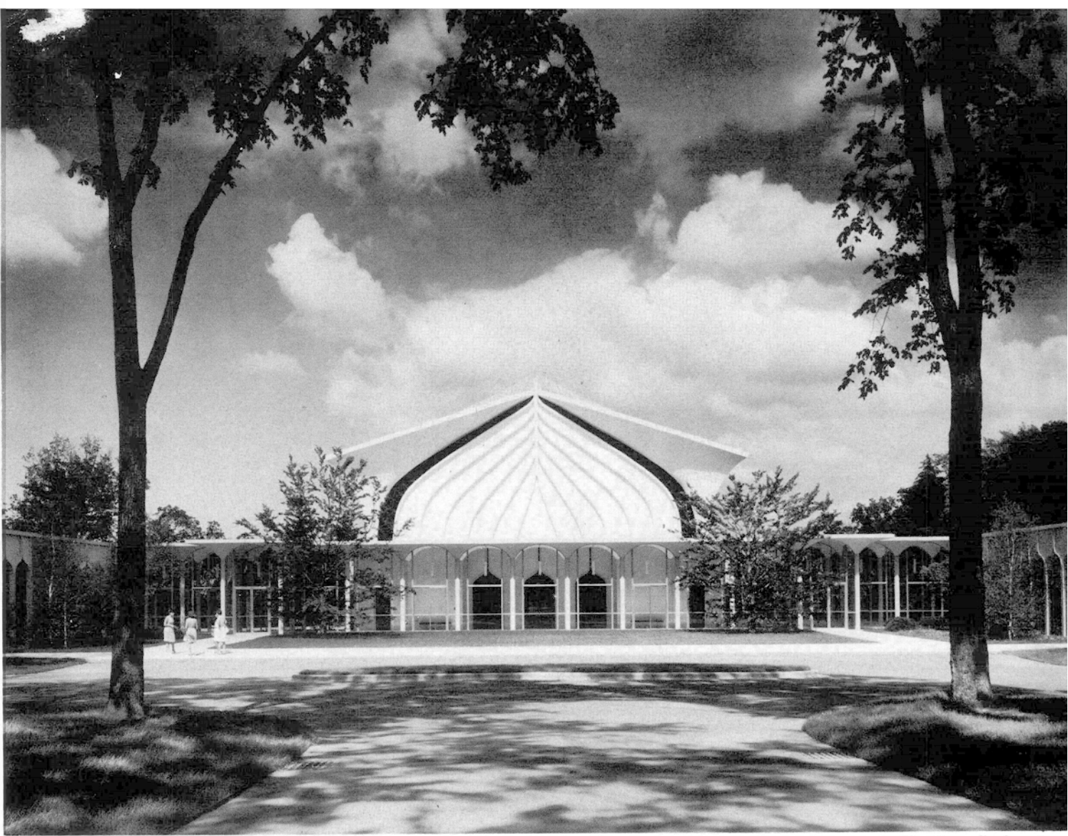
Fachada principal de esta edificación realizada con elementos precolados.
