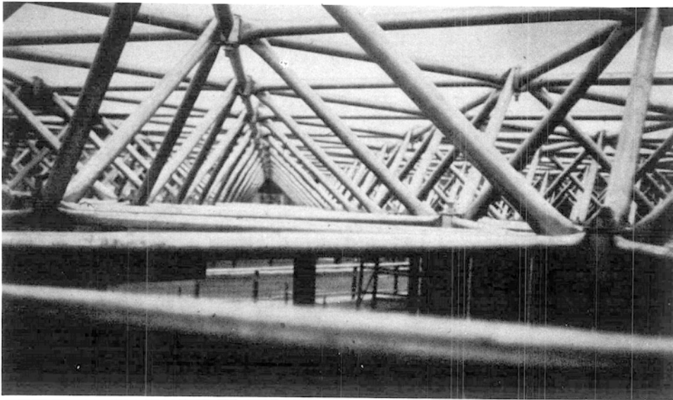
Estructuras modulares geodésicas forman las cubiertas de esta obra.
