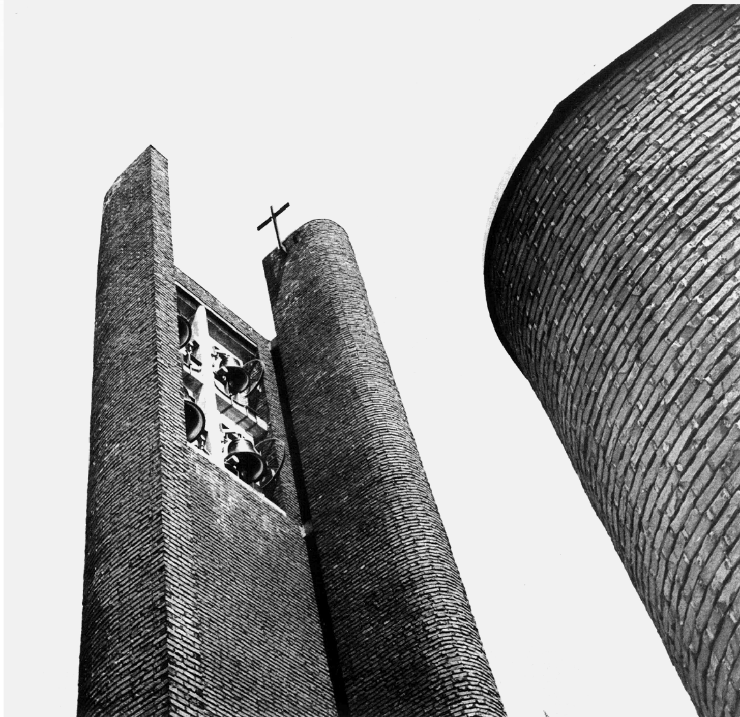
Detalle de la torre y campanario.
