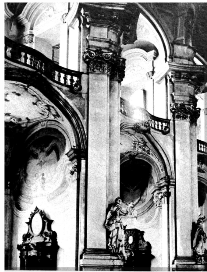
Detalle interior, de la nave de la iglesia Jesuita de San Nicolás (1704-1711). Parte norte.
