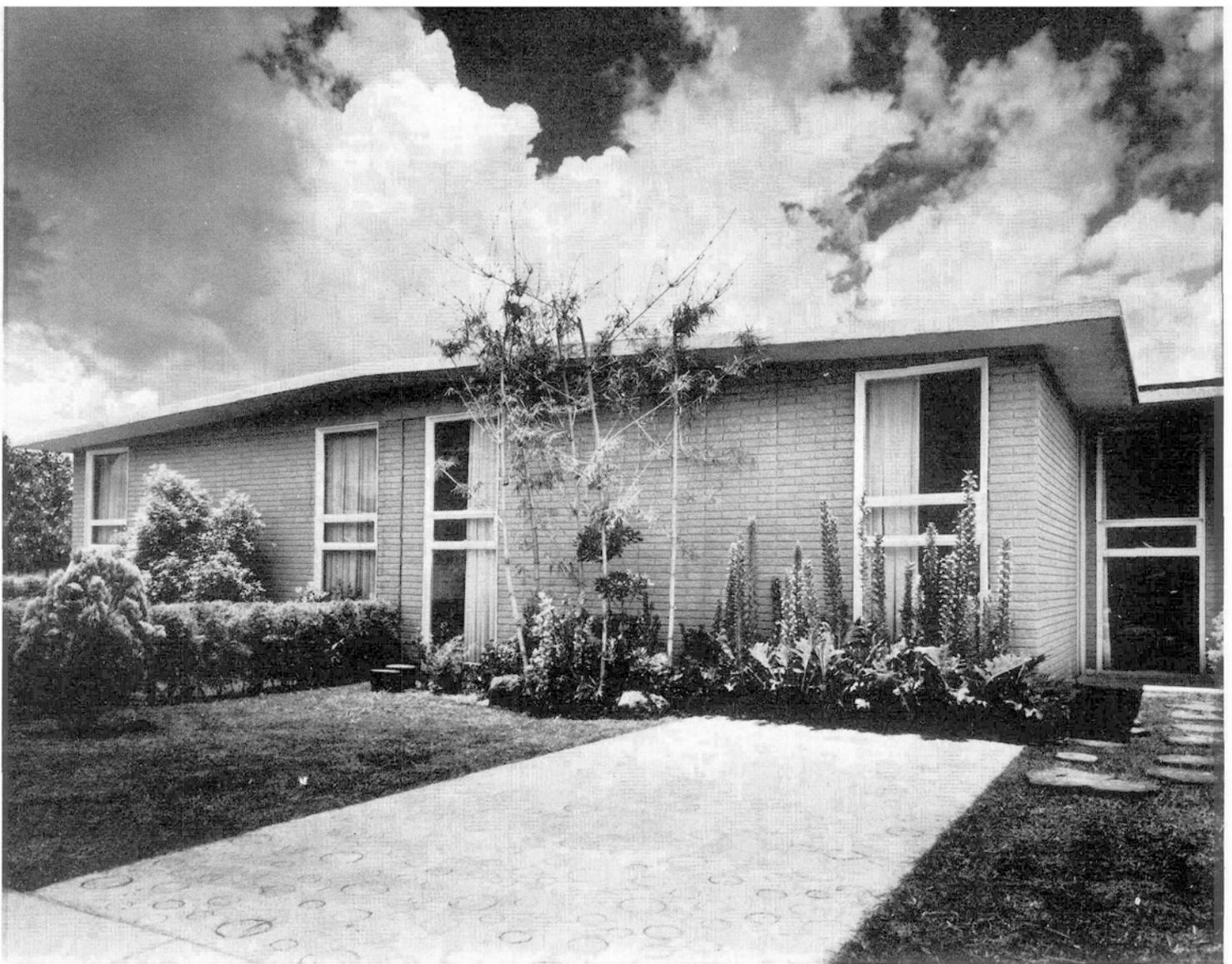
El uso de cimbras metálicas permite cualquier textura en los muros que aunado a la calidad del acabado dan además resistencia y durabilidad.
