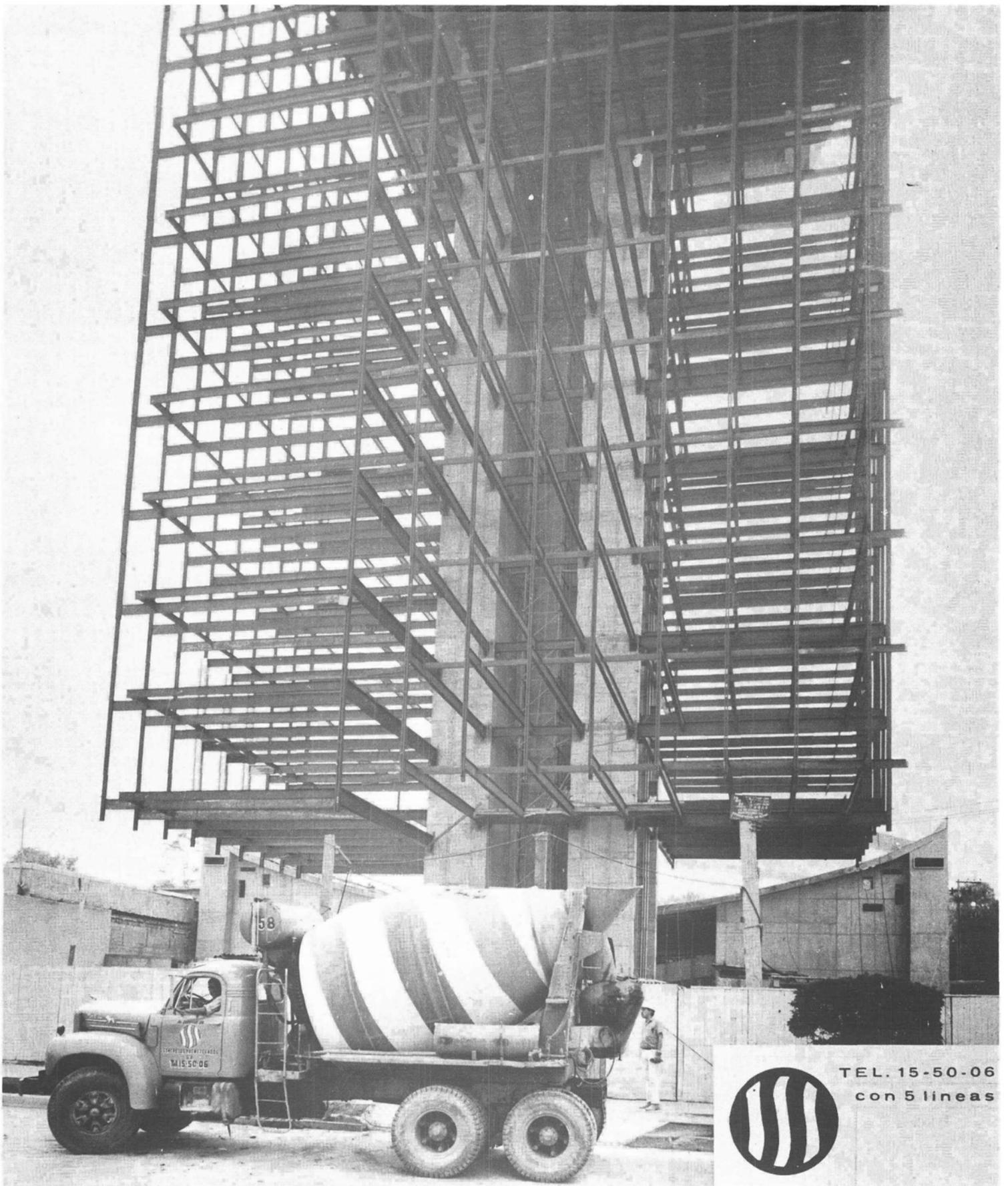
El concreto premezclado se dosifica por peso y está hecho con agregados seleccionados y graduados. Resistencia verificada por el Laboratorio de la Asociación Nacional de Concreto Premezclado, A. C.
