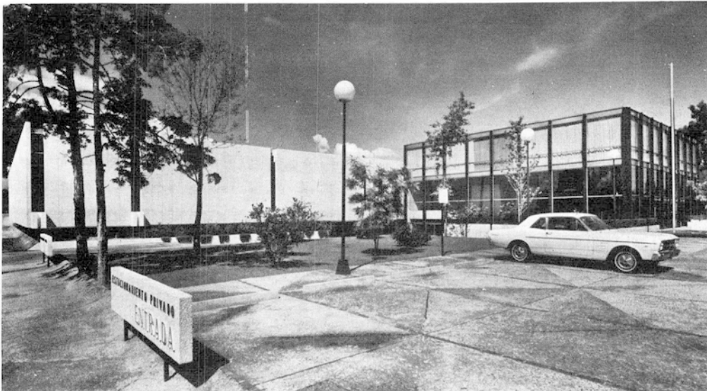
Vista parcial de los elementos que forman la fachada principal.
