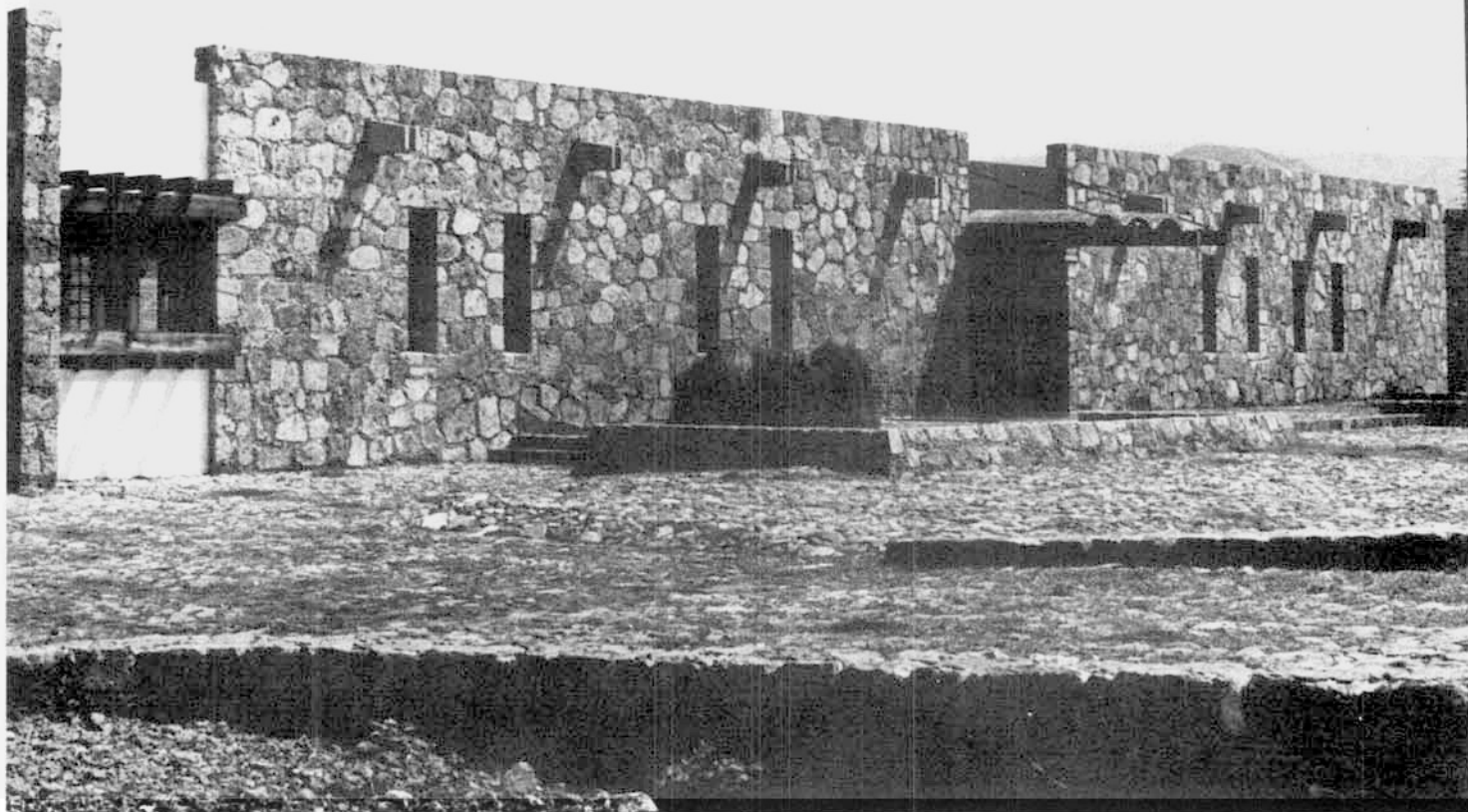
Exterior de esta instalación administrativa.
