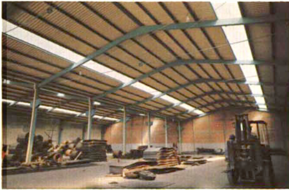
Techo PINTRO instalado en "METALICOS ARMEBE, S. A."
