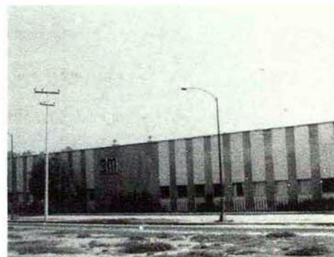
Utilización de muros y losas SPANCRETE en un edificio industrial. Ahorran costo, peso muerto y tiempo; permiten salvar claros hasta de 15 metros sin apoyo intermedio.
