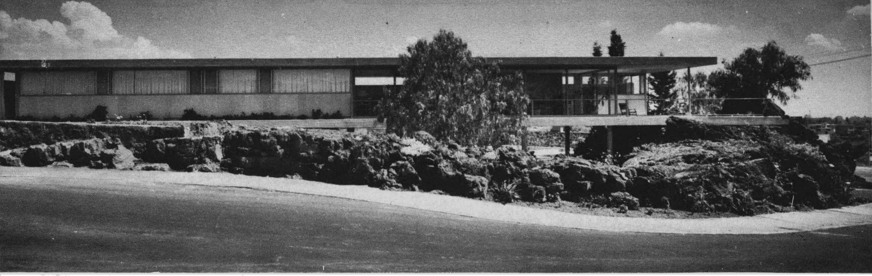
● VISTA GENERAL DE FACHADA
