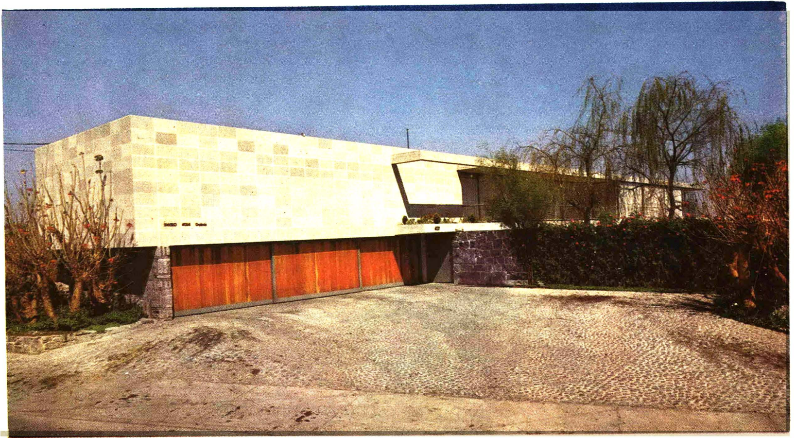
FACHADA A LA CALLE ●
