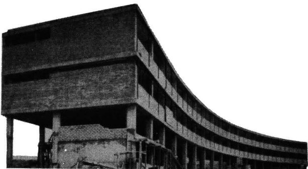
NUEVO EDIFICIO PARA EL COLEGIO "VALLARTA" CIUDAD SATELITE, ESTADO DE MEXICO PROYECTO Y REALIZACION: ARQ. EUGENIO URQUIZA
