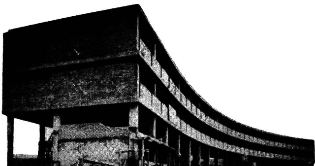
NUEVO EDIFICIO PARA EL COLEGIO "VALLARTA" CIUDAD SATELITE, ESTADO DE MEXICO PROYECTO Y REALIZACION: ARQ. EUGENIO URQUIZA
