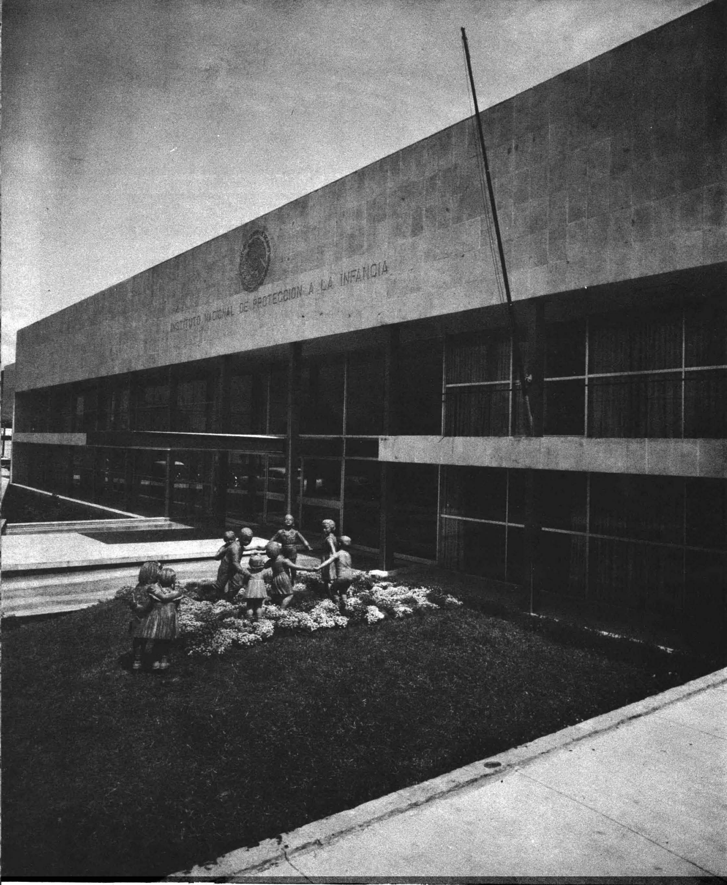
FACHADA INTEGRAL DE ALUMINIO EN EL INSTITUTO DE PROTECCION A LA INFANCIA ARQS. PEDRO RAMIREZ VAZQUEZ Y RAFAEL MIJARES
