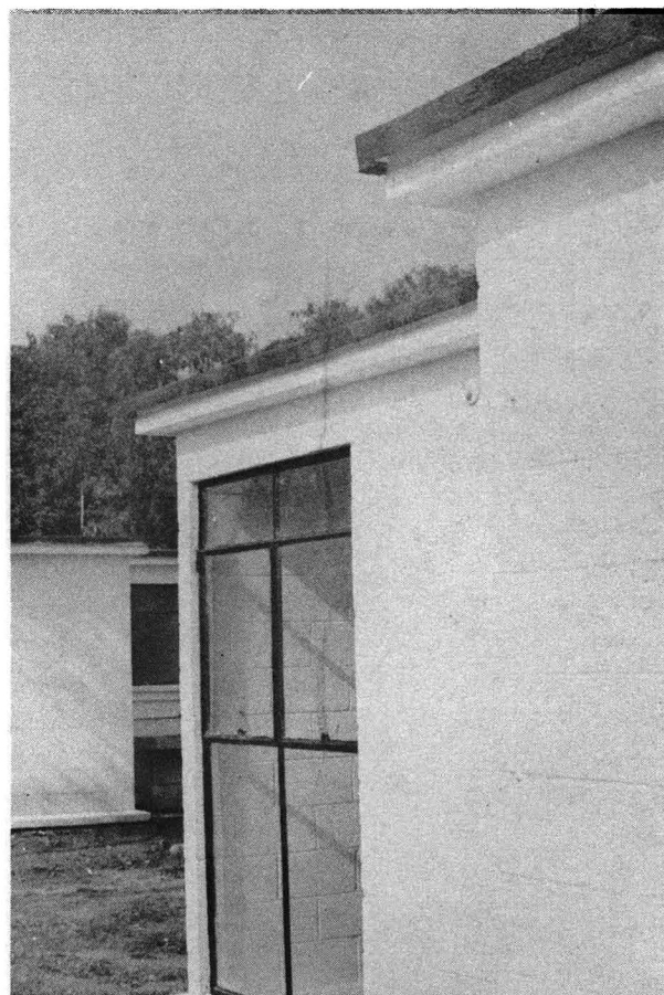
CASAS habitación para los trabajadores de LA TOLTECA . Arq. Samuel Moreno. Constructora Dinámica, S. A.
