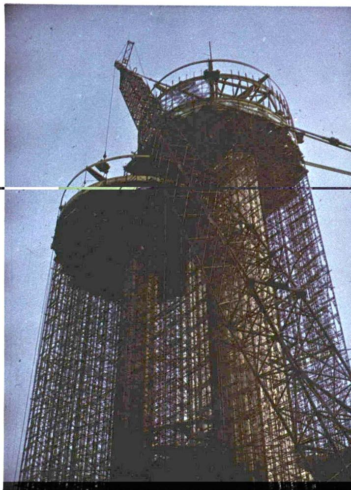
pies en su arista. El diseño de paredes circulares sujetas a momentos de doblado en sus cimas, así como en sus puntos intermedios, es interesante y resulta una solución económica para una estructura complicada.
