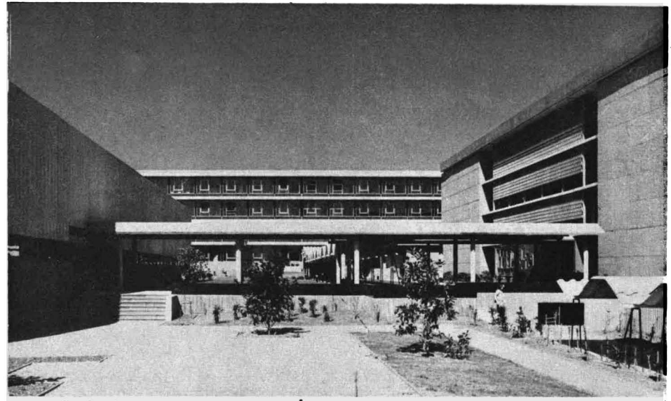
Vista desde el eje central / View from the middle axis
