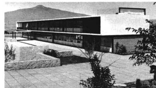
Aulas para secundaria técnica / Middle technical school. Classrooms
