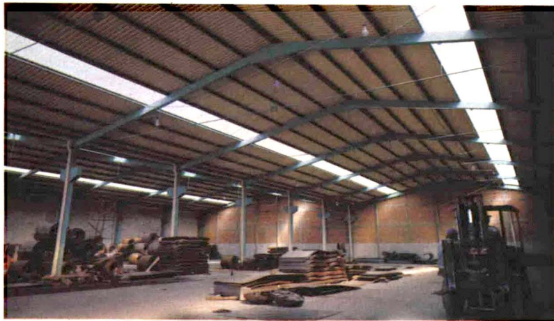
Techo PINTRO instalado en "METALICOS ARMEBE, S. A."
