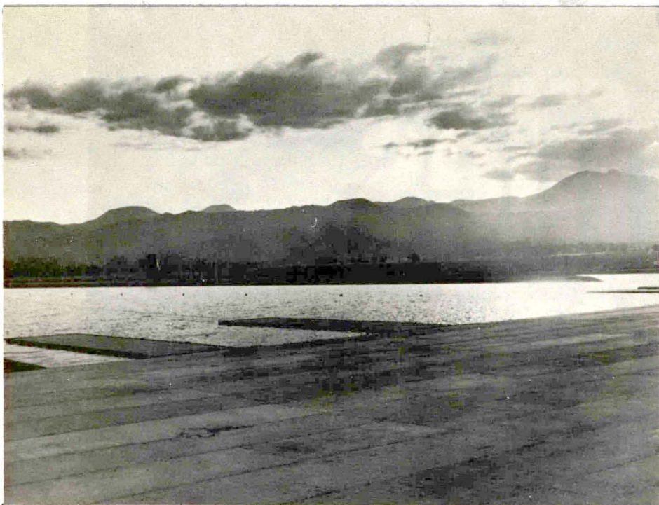
Canal de Cuernavaca C. M. Construcciones, S. A.
