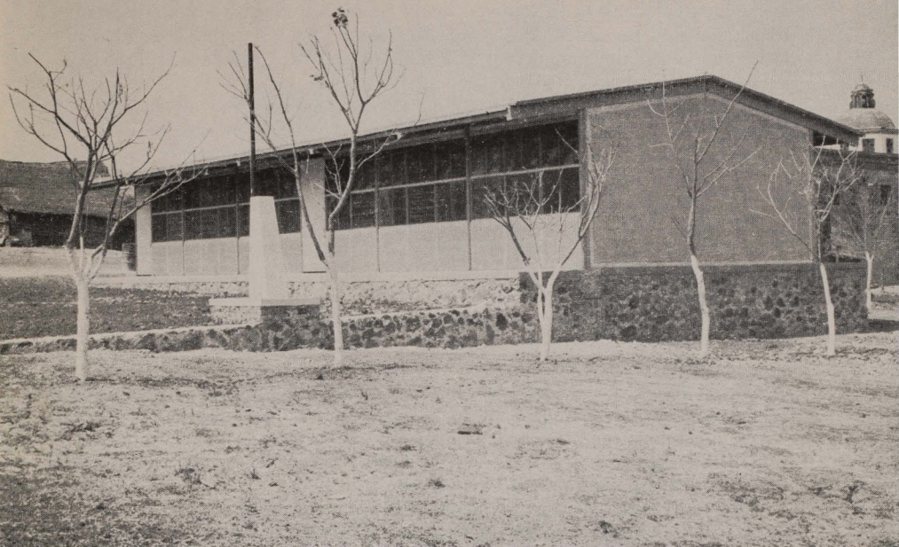
El proyecto del Aula-Casa Rural se adapta a las condiciones locales de clima y topografía pero conserva la estructura y el mobiliario prefabricados.
