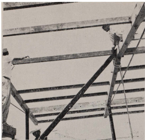
Proceso de montaje de la estructura metálica prefabricada.
