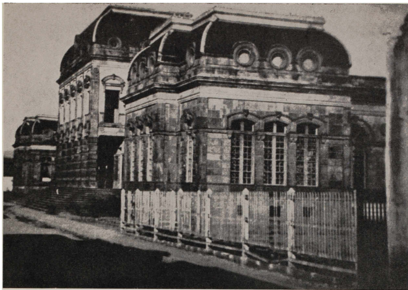
Como ejemplo de un edificio fuera de la ciudad de México, está la Escuela de Tenango del Valle, en el Estado de México. Una población pequeña, que a principios de siglo no debe haber tenido más de 2,000 habitantes, se desarrolla con un piso entresolado levantado cerca de 1.80 de altura, más lo que tuviera bajo tierra; las aulas tenían 4.50 metros de altura. La parte de arriba era destinada exclusivamente a biblioteca y dirección; entre una y otra crujías de aulas existe un pasillo. Este es un proyecto copiado y adaptado de los planos de una biblioteca que se construyó en algún lugar de la Unión Americana.
