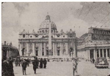
82. Basílica de San Pedro, Roma. Conjunto de la fachada principal, de Maderna, cuya composición anarmónica está fundamentalmente fuera de escala.
