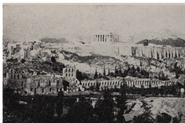
108. Fotografía de las ruinas. Nótese lo mismo que en las anteriores fotos.
