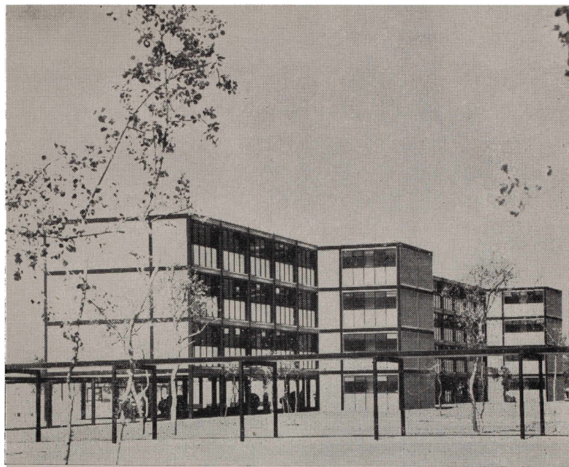
Aulas, edificio tipo Fachada Norte
