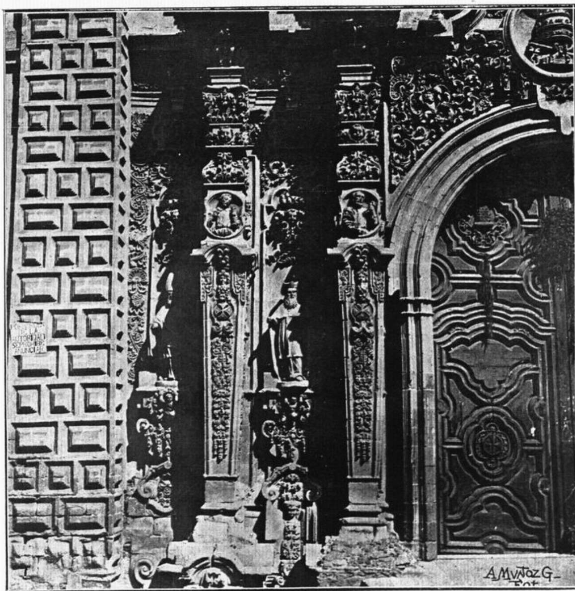
Detalle del cuerpo bajo de la Fachada.
