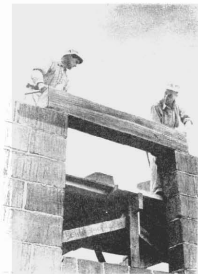
Los cerramientos de puertas y ventanas pueden colocarse directamente sobre las aberturas respectivas
