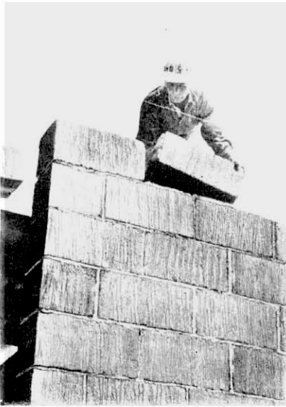
Construcción de un muro exterior con bloques de Ytong.
