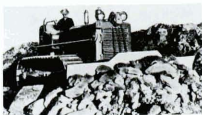
Tractor TD-24 con Niveladora de Empeje, controlada por cable.
