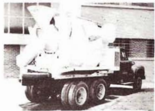
Mezcladora de concreto montada sobre camión, con capacidades desde 2.6 hasta 6.8 metros cúbicos. Se pueden operar como agitadores, para obtener mayores capacidades.
