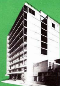
EDIFICIO DE APARTAMENTOS EN HORACIO No. 340, MEXICO, D. F. PROYECTO Y EJECUCION: ING. N. DAGDUG
