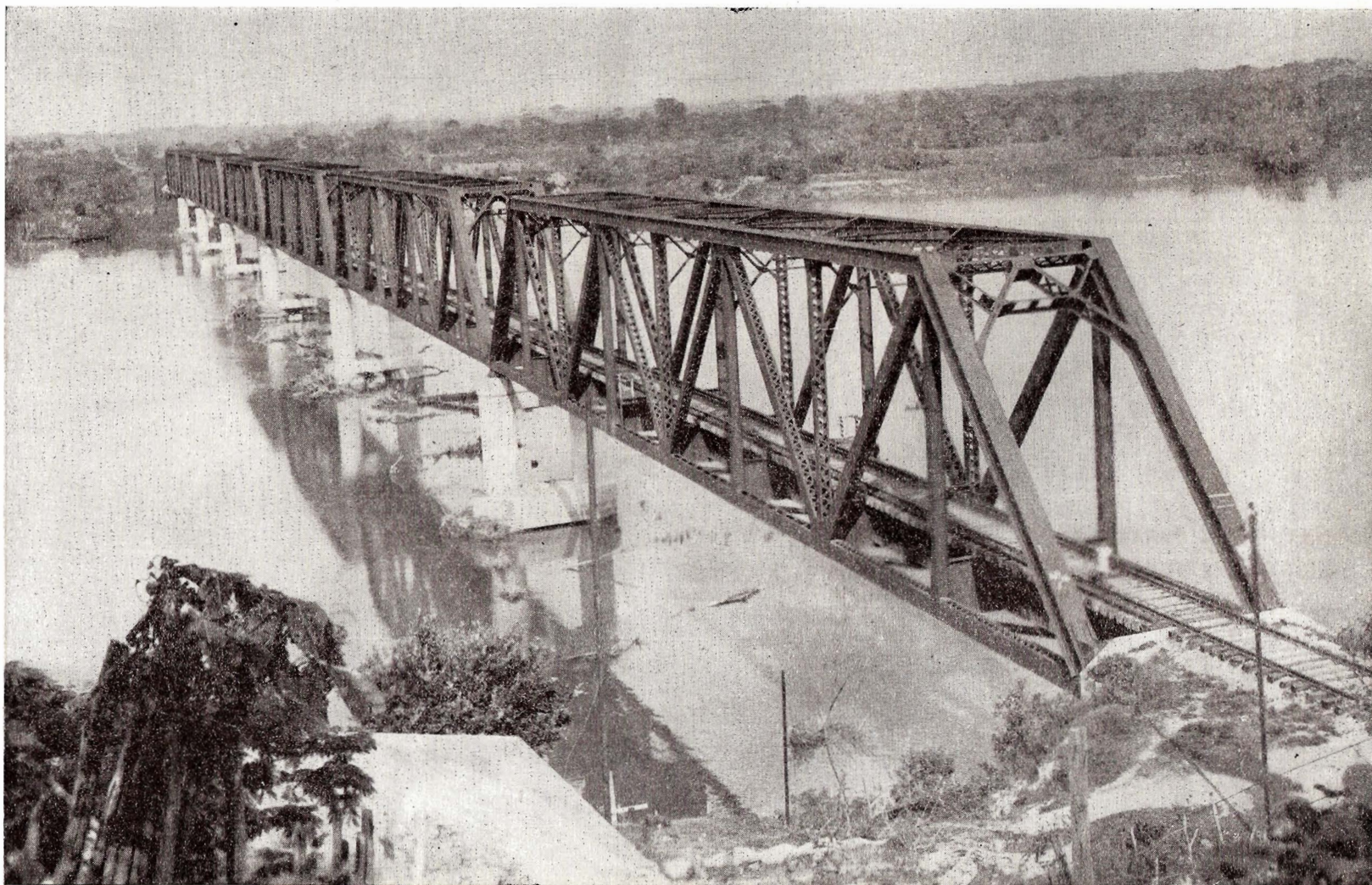
MEXCALAPA ARMADURAS DE 7 cm. DE ACERO DE PASO A TRAVES, CABALLETES DE 2 COLUMNAS DE CONCRETO REFORZADO. LONGITUD, 496.62 m.
