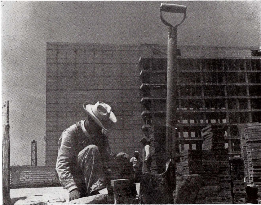
...SE ESTUDIO PARA SU APROVECHAMIENTO LA ESTRUCTURA DEL SEGUNDO HOSPITAL DE ZONAS DEL IMSS, ABANDONADO DURANTE TANTOS AÑOS...
