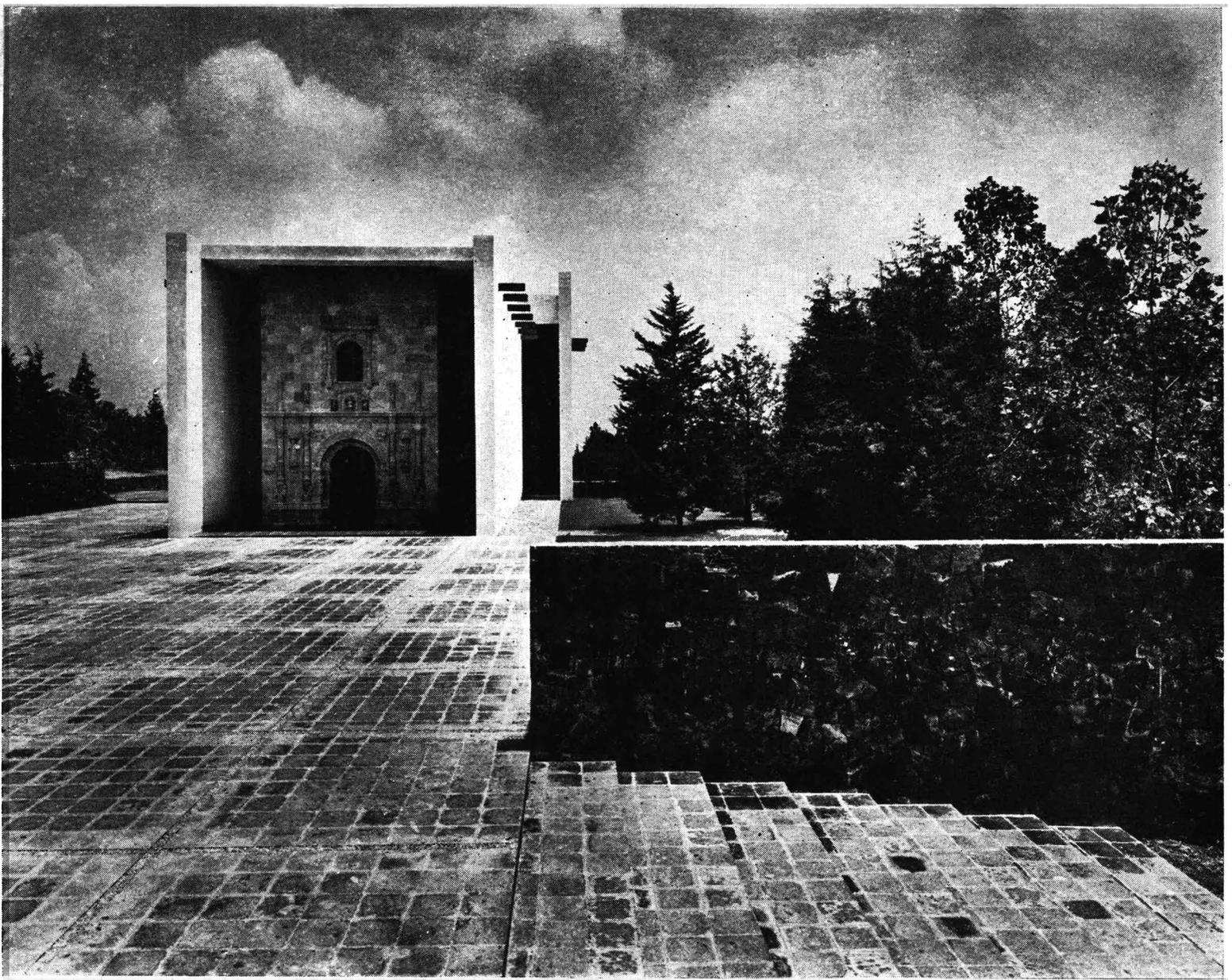
Exteriormente los muros se trataron con el mismo criterio del exterior: grandes paños enlucados, en los cuales se colocaron unas gárgolas o chorreras de piedra que producen sombras sobre los muros, y que sirven para el desagüe de la azote plana.
