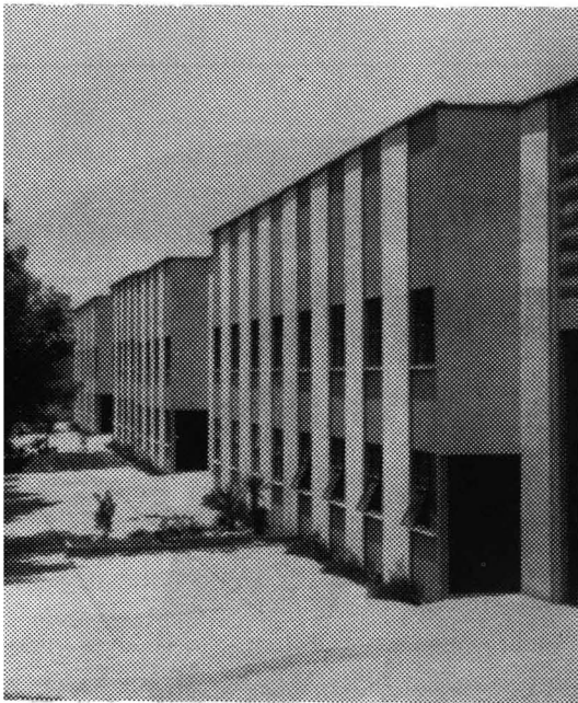
a).- Fachadas de las bodegas b, c y d terminadas recientemente en Naucalpan de Juárez, Estado de México.
