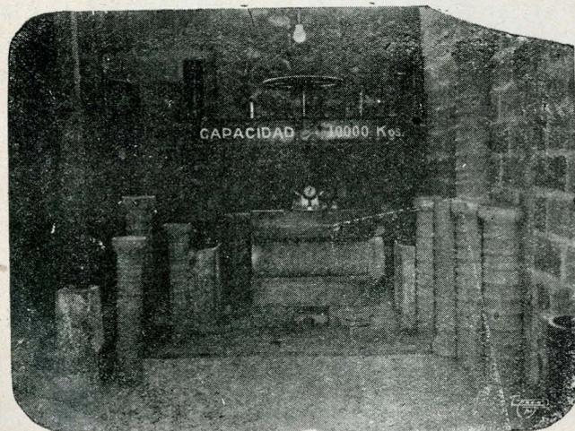
Máquina para probar los tubos de concreto en los laboratorios de la fábrica.
